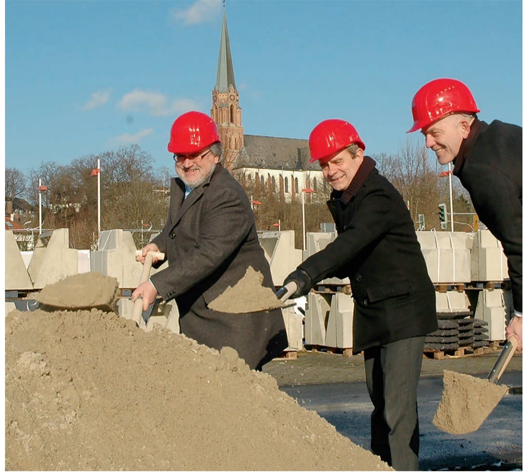
Friedrich-Wilhelm Rebbe, Michael Dubbi von der LWL Geschäftsleitung und Bahnhofsmanger Jörg Seelmeyer (v.l.) beim ersten Spatenstich für den sechs Millionen teuren Umbau des Bahnhofes am 4. Februar 2015.
