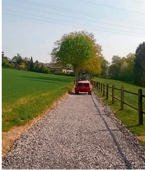
Die Bauarbeiten am Radweg zwischen Gesamtschule, Frörmern und Ostbüren konnten wie geplant stattfinden.
